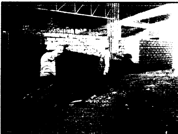
Foto N° 11 y 12: construcción de muros de ladrillo, sobrecimientos, y vaciado de zapatas en Area de Administracion reubicada
