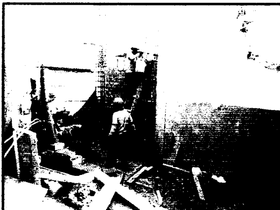
Foto N° 05 y 06: vaciado de concreto de columnas y columnetas del Bloque de Administracion.
