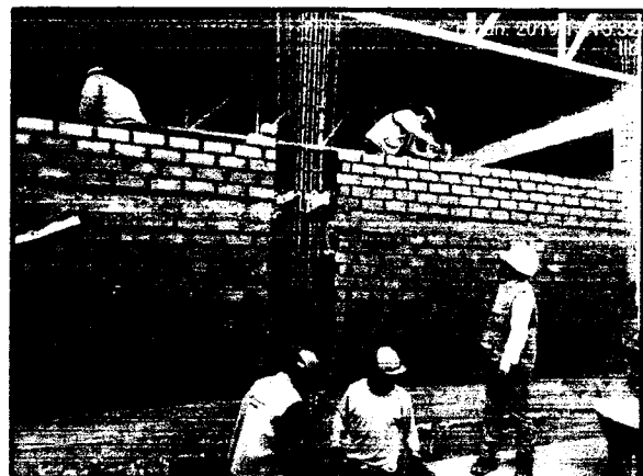
Foto N° 11 y 12: construcción de muros de ladrillo, sobrecimientos, y vaciado de zapatas en Area de Administracion reubicada
